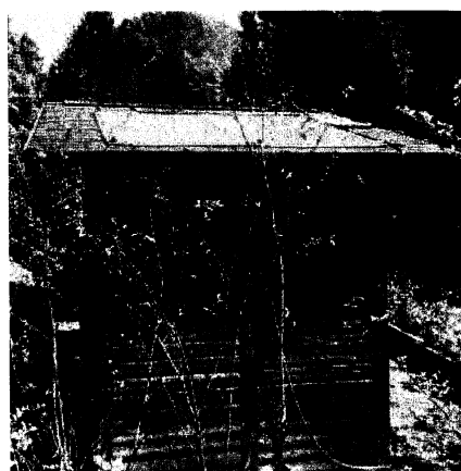
図6 京都大学北白川試験地ログハウスに設置された集熱パネル
