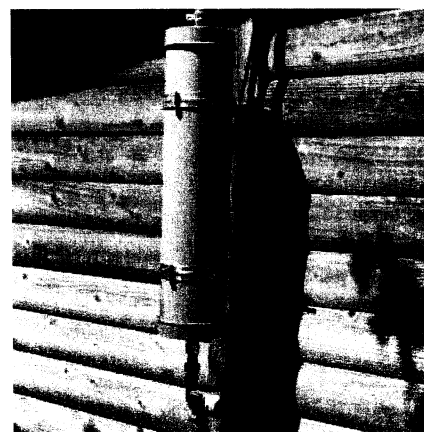
図7 温水循環タンク
