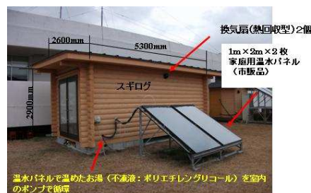
図2 ログハウス型木材乾燥室(兵庫県森林技術センター)
